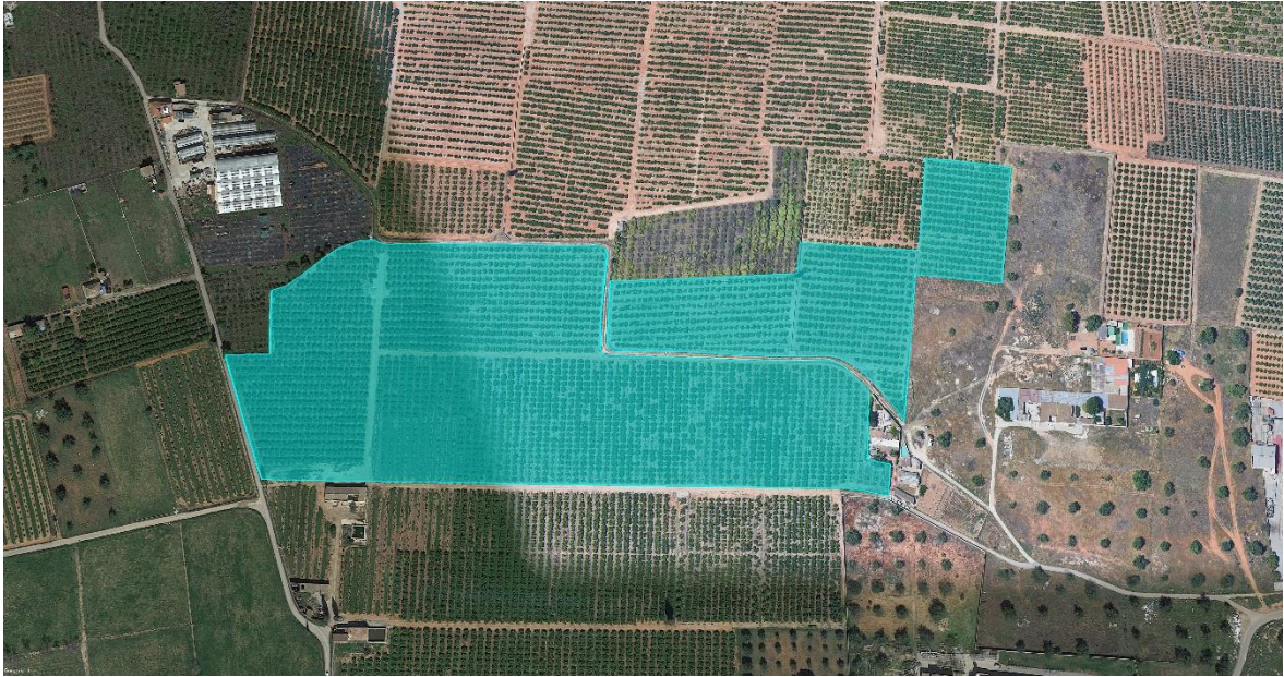
Ilustración 2: Ubicación de la Planta Solar Fotovoltaica Híbrida.
