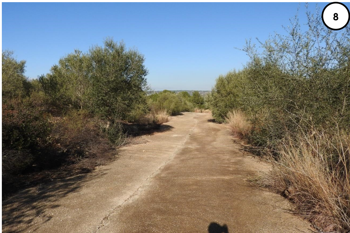
Ilustración 10: Vial existente que atraviesa la PSFH Canals
